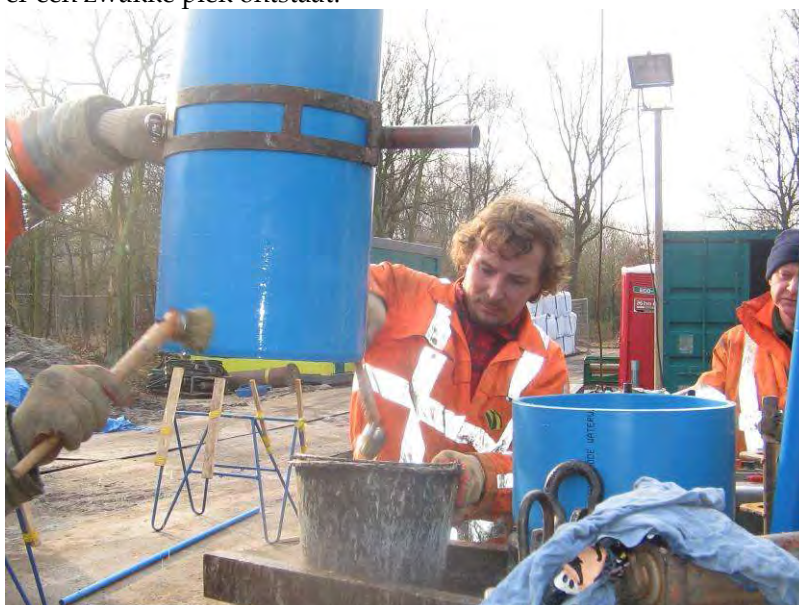
Figuur 11-10 Lijmen spie-eind en mof (foto Carl van Rosmalen, Brabant Water)
