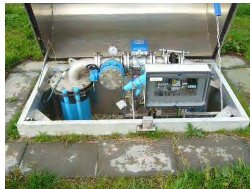
Figuur 8-5 Bovengronds afgewerkte pompput. (SBW, 1995) Rechts:: foto bovengronds afgewerkte put in Onnen (Waterbedrijf Groningen)
