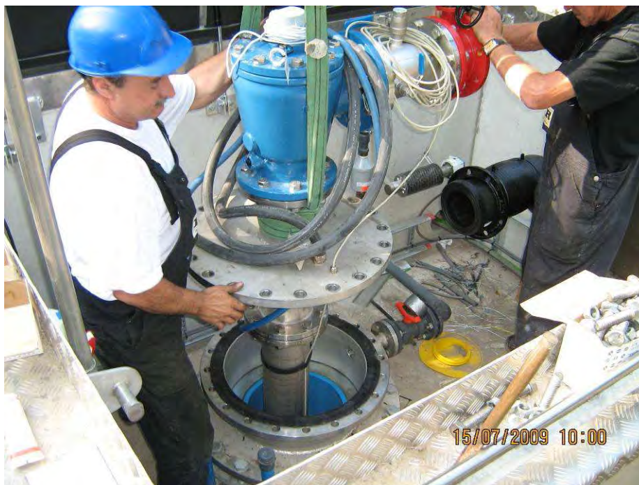
Foto 11-4 Het installeren van een pomp, haalbuizen en watermeter (Carl van Rosmalen, Brabant Water)
